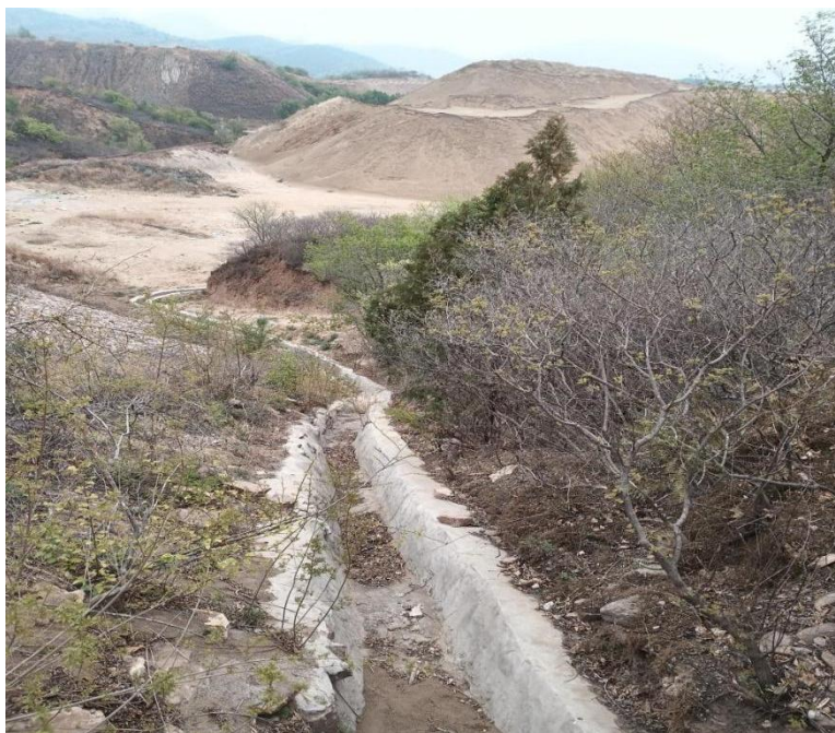
图 2-10 初期坝坝肩排水沟
