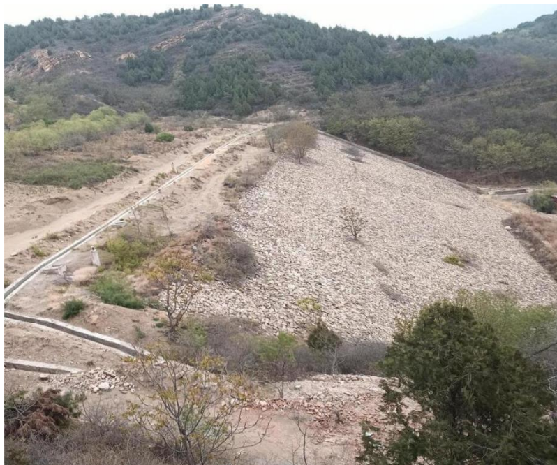
图 2-4 初期坝坝体（现状）
