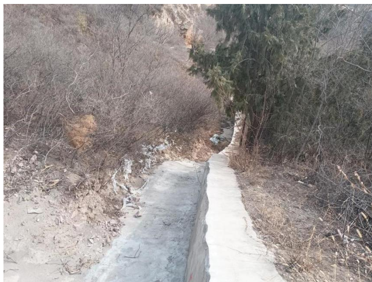
图 2-11 堆积坝坝肩排水沟
