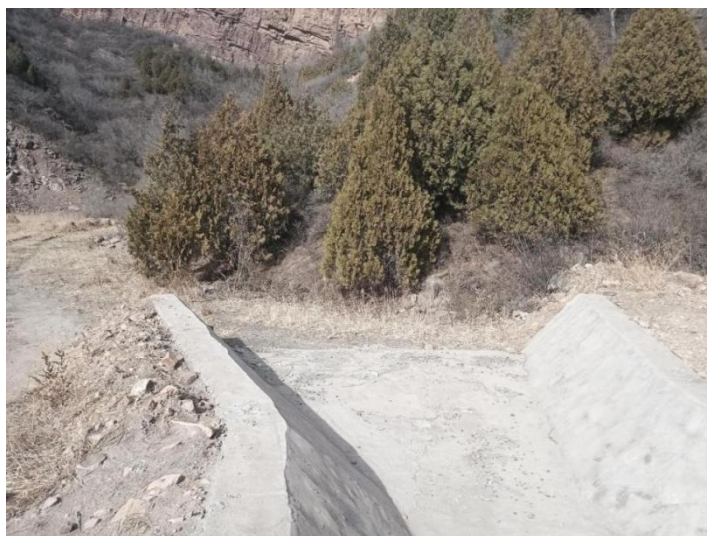
图 2-8 溢洪道进流段
