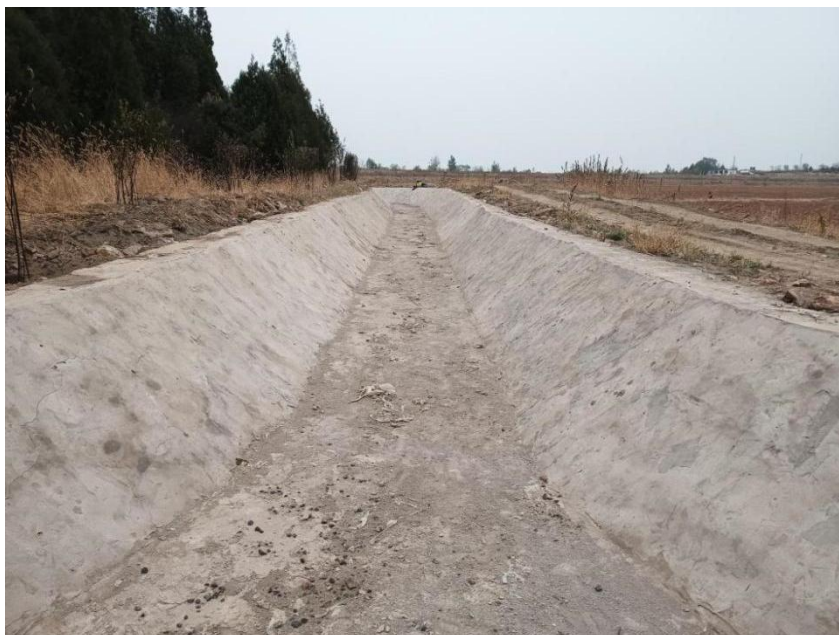
图 2-9 溢洪道泄流段
